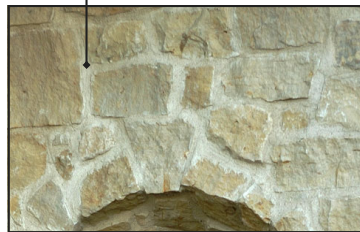
Sydney (Overgrout) shown
